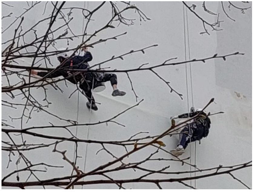
"Dança na empena" A atividade de pintura em alpinismo Autor: Pedro Rocha
